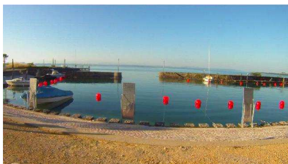
Le port de Serrières...un peu déserté... mais en travaux
