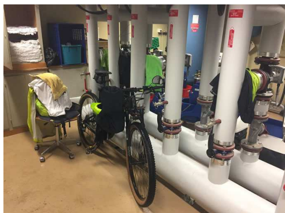
Dans mon local vélo au CPLN qui est en fait celui du système de chauffage
