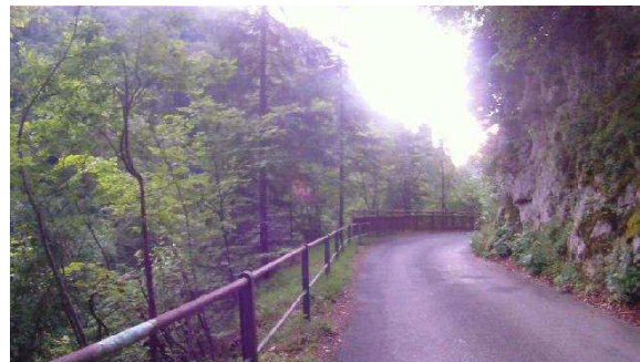
La descente des gorges de l'Areuse juste avant l'usine électrique
