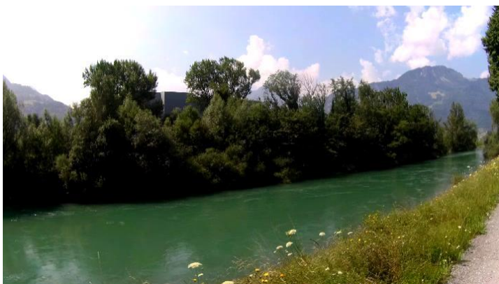
Le canal de la « Linth » reliant les lacs de Walensee et Zürich Niederurnen
